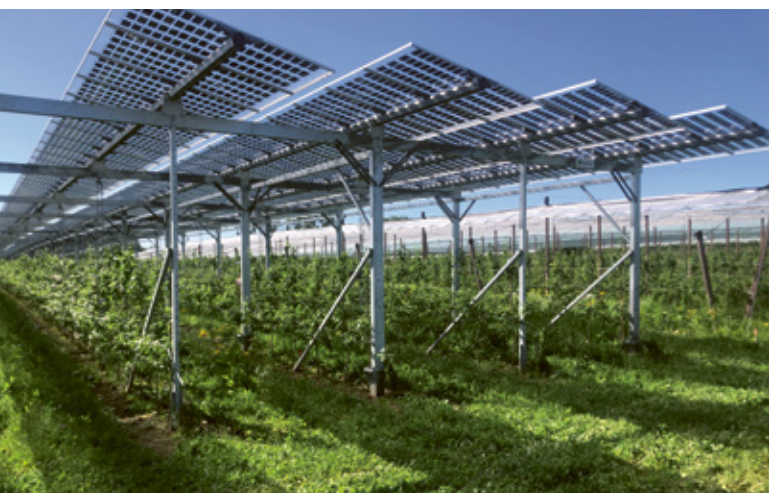
Agriphotovoltaik-Anlage des Obsthofes Nachtwey in Gelsdorf
