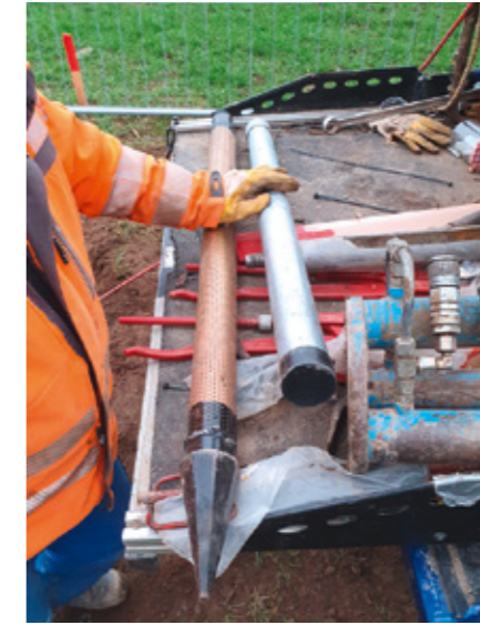
Rammfilter für die Grundwassermessstelle
