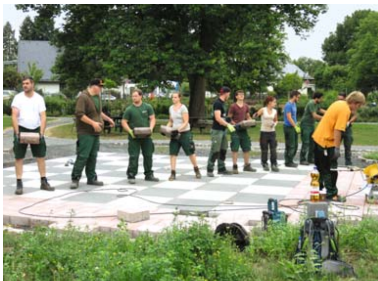
Beim Bau des Schachfeldes packen alle mit an.
